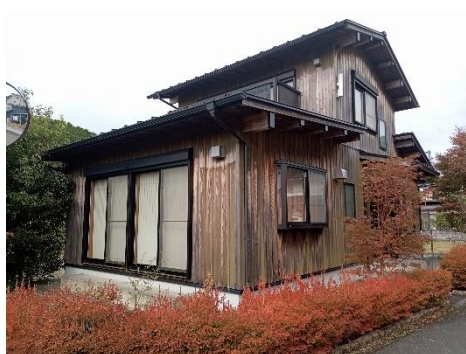
中間管理住宅・外観
