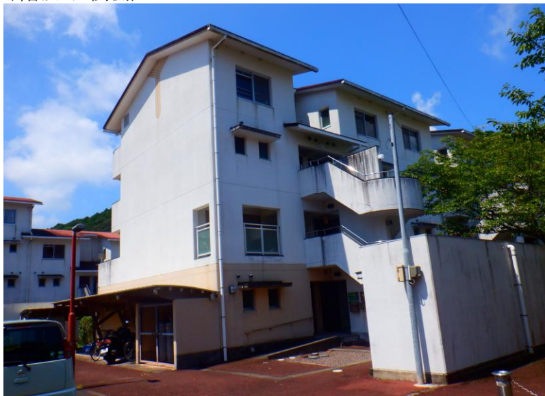
外観(外階段・玄関側)
