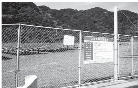
太田太陽光発電所
