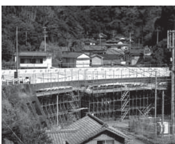
大津橋梁撤去工事
