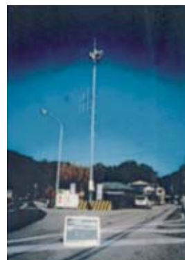
防災行政無線 屋外子局の設置
