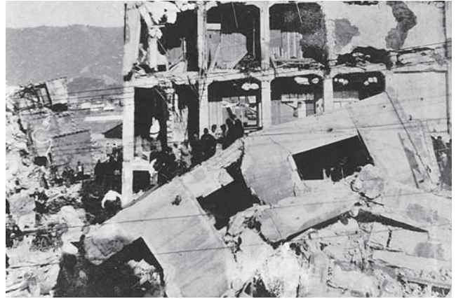
ビルの倒壊 高知市堺町付近
