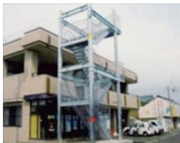
津波避難ビルの整備 外付け階段の設置
