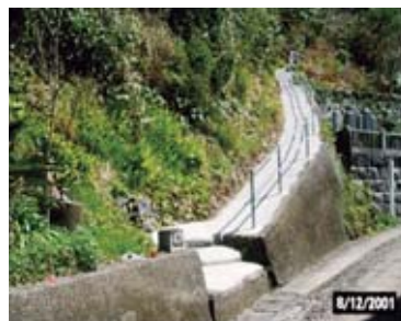
避難路の整備
