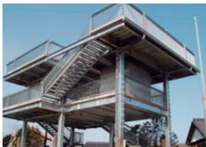
津波避難タワー
