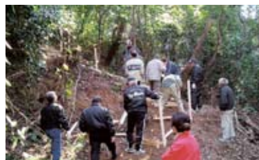
② 避難路の整備（高知市浦戸地区）
