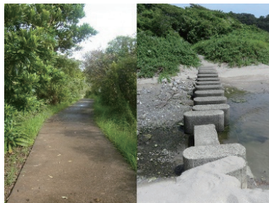
遊歩道の現状
