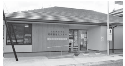
竜串福祉センター改築工事
