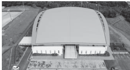
土佐清水総合公園体育館屋根改修
