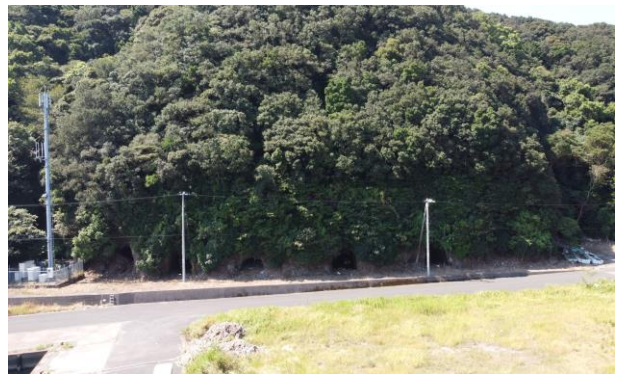
↑第 132 震洋隊・残存格納壕
