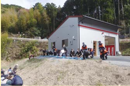
加久見部消防屯所
