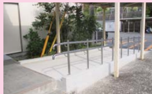
バリアフリー化された通路の整備
