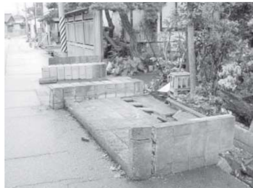
地震により、倒壊したブロック塀(平成19年新潟県中越沖地震)
