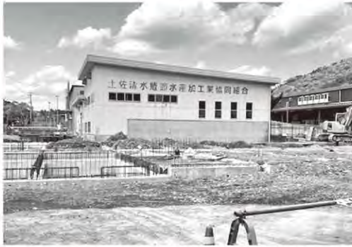
建設中の土佐清水市共同加工施設
