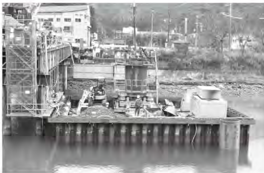
下ノ加江橋の工事の様子
