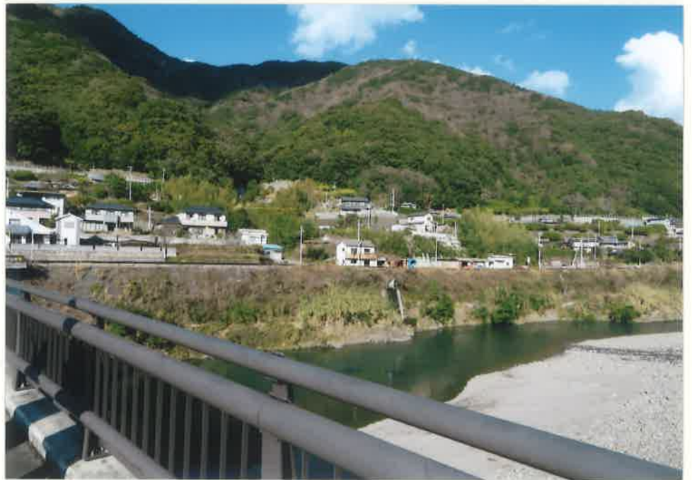
日高川町崩落防止施設
