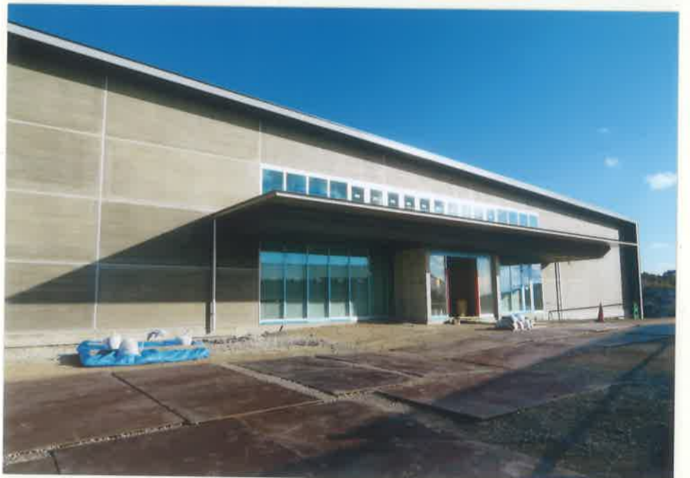
日高川町防災センター (建設中)
