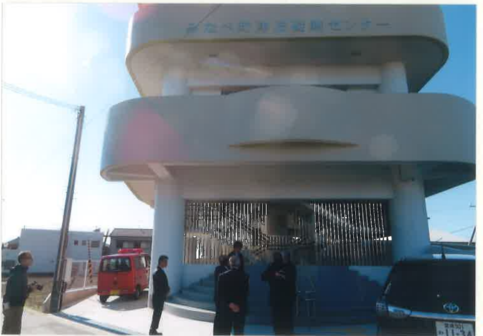
みなべ町避難タワー
