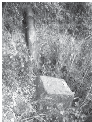
益野発電所水路跡
