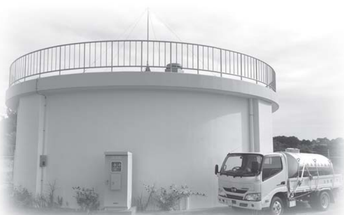
給水タンクと給水車
