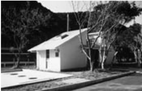
（写真）左上：浦尻運動公園トイレ改築 右上：総合公園芝生園地 左下：竜串海洋レジャー施設 右下：下ノ加江海浜公衆トイレ・炊事棟
