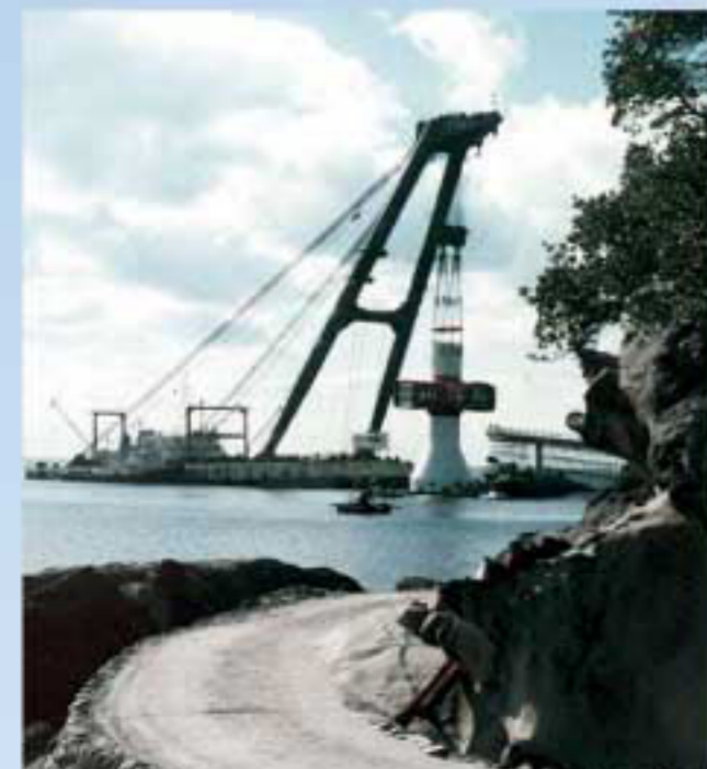
取り付け工事
