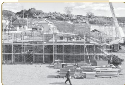
建設が進む中央公民館
