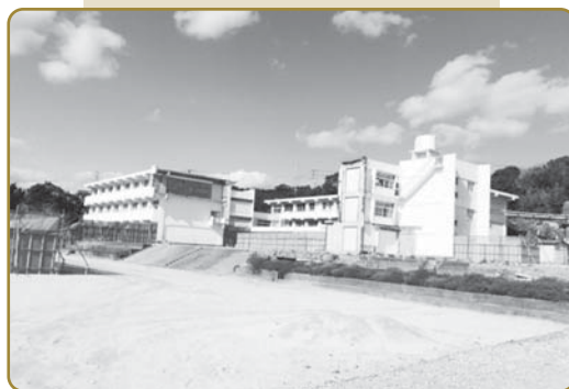
これから建設が始まる清水小学校校舎
