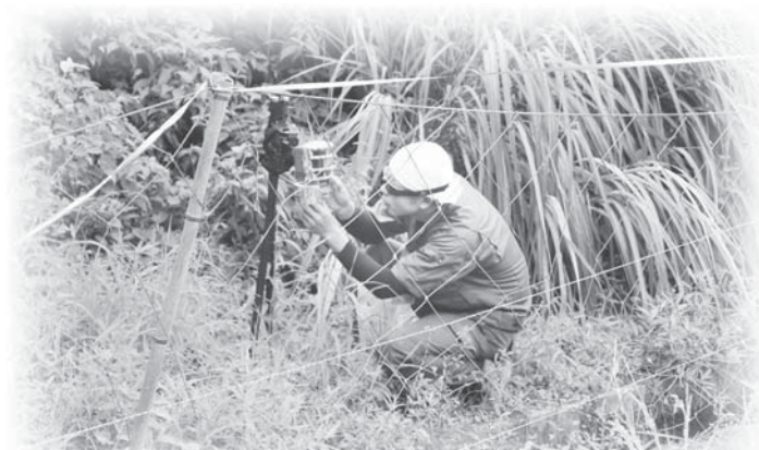
有害鳥獣から農作物を守るための電気柵・監視カメラを設置する様子
