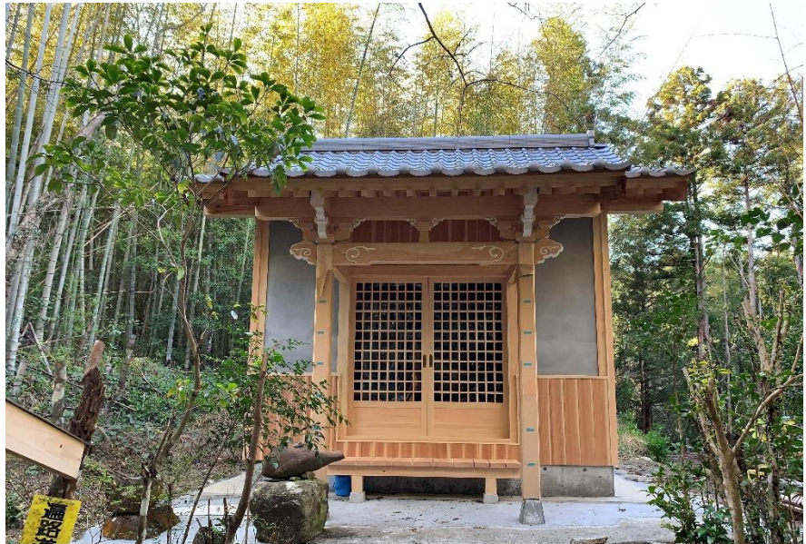
(写真1) 令和2年2月に落慶した真念庵新堂舎
